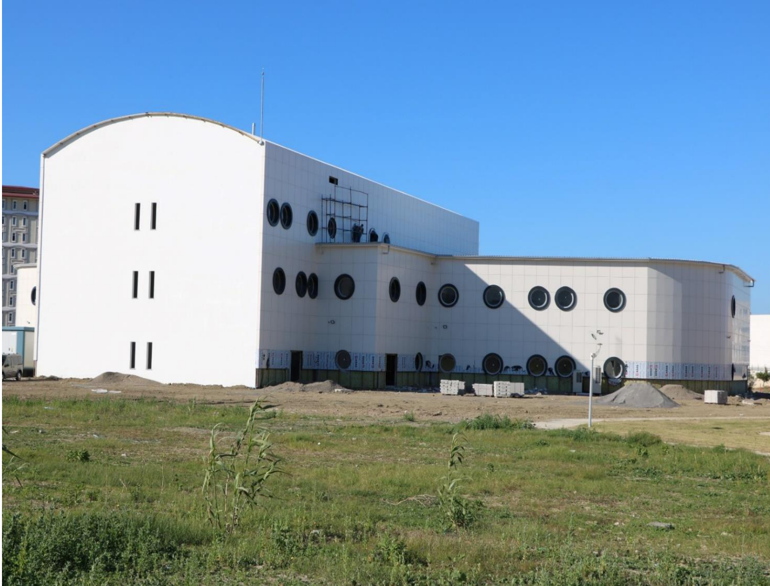
Resim 1. Hangar ve Atölyeler Binası
