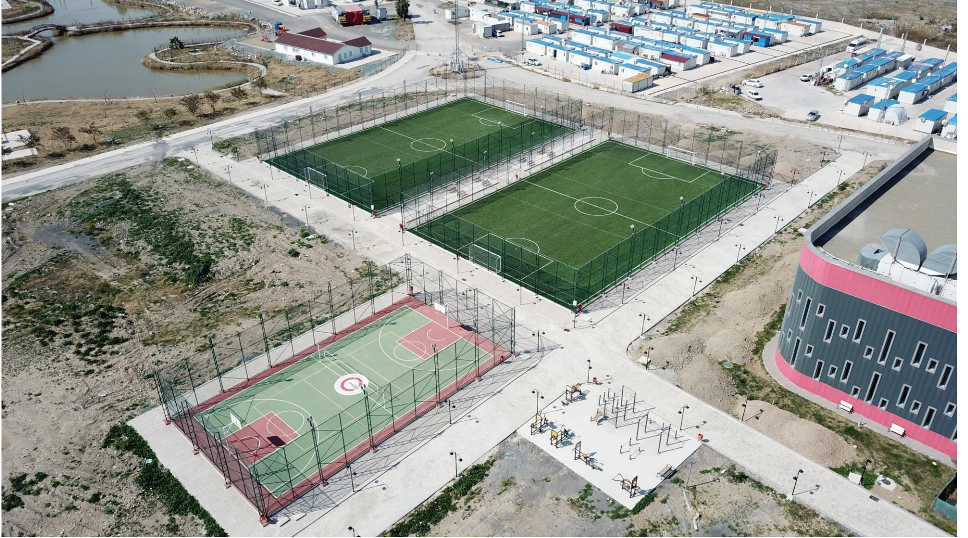
Resim 8. Merkez Kampüs Açık Spor Tesisleri Yapım İşı 1. Etap
